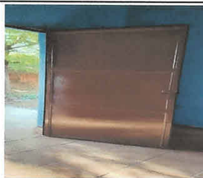
Foto 6: Restauracion de puertas de aulas
