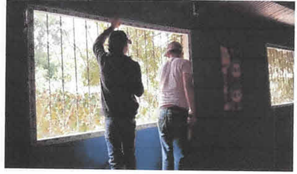
Foto 8: Instalación de ventanas PVC
