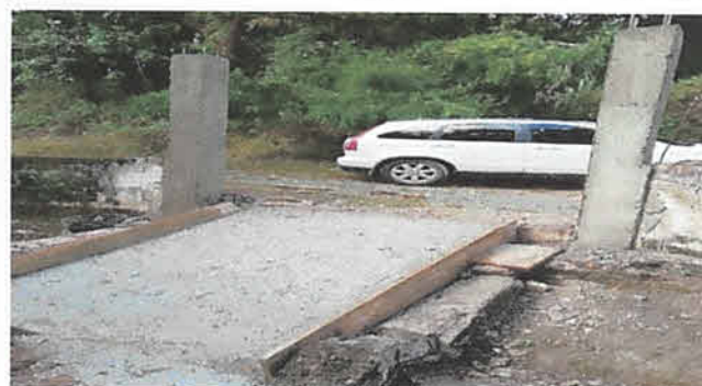
Foto 4: Restauración de area de ingreso.
