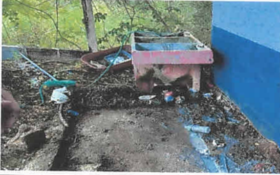
Foto 7: Instalación de pila de dos lavaderos
